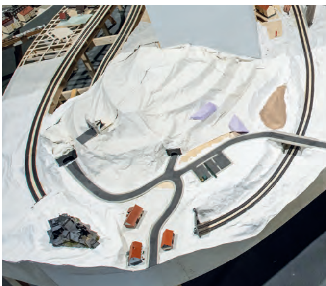
Unterste Schicht: Unter der dünn eingespachtelten Landschaftsfolie geben Dachlatten den abgestuften Geländeverlauf vor.
