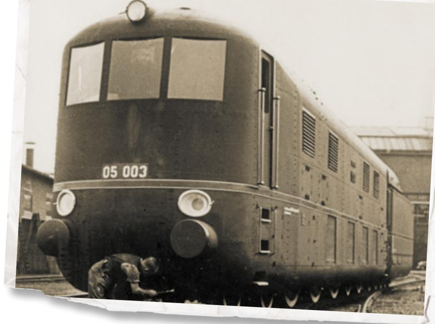
Vorausschauend: Der aerodynamische Führerstand der 05 003 prägt das „Gesicht“ späterer Schnellzugloks. An der Stirn oben das Zugbegegnungslicht.
