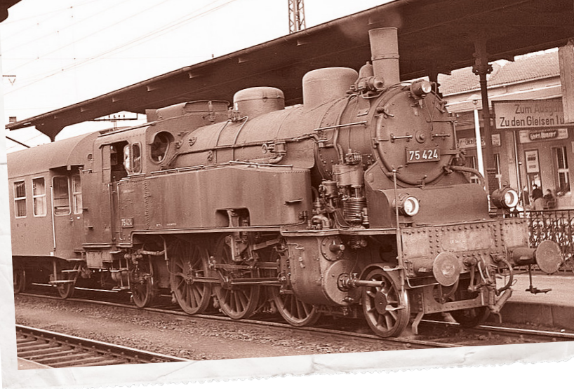
Lokführerseite: Eine Lok der BR 75.4 wartet im Freiburger Hauptbahnhof mit einem Personenzug auf die Abfahrt nach Bad Krozingen. Vor der Rauchkammertür sitzt der verblendete Speisewasservorwärmer.
