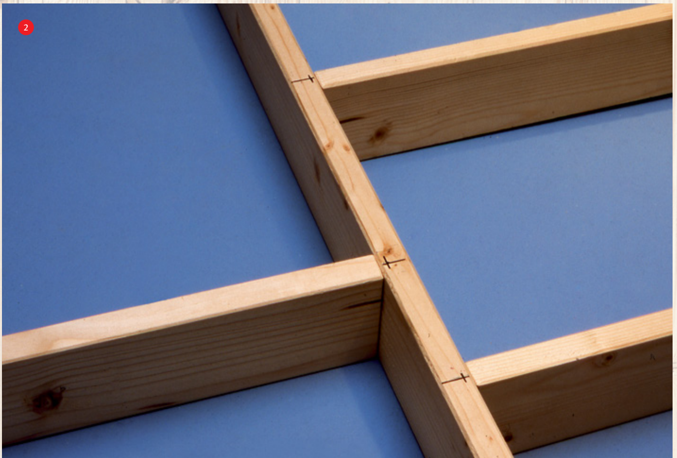
Genau holzmittig werden die Seitenstreben an den Dornmaßen befestigt. Die zusätzlich zu den Dornmaßen parallel zur Leiste angebrachten kleinen Strichmarkierungen zeigen die Seite, an der die Strebe zu befestigen ist. Die Dornmarkierung alleine gibt hierüber keine Auskunft.
