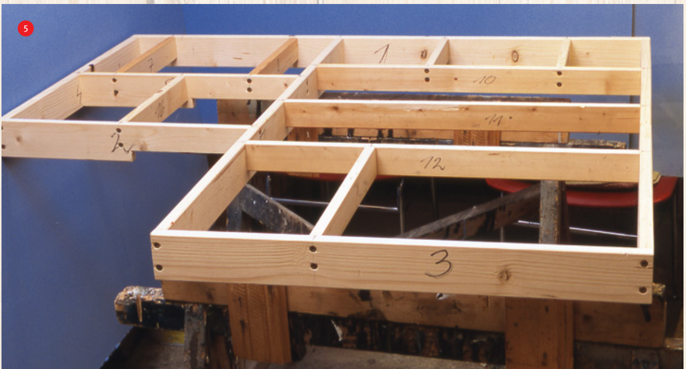
Hier präsentiert sich auf unseren Werkstattböcken der fertige Grundrahmen in seiner oberkantenbündigen und planebenen Form. Gut zu erkennen sind die Ladenaussparungen an den Rahmenteilen 2 und 9.
