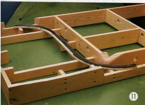
Der untere Wendestrecken-Teilbereich ist samt Fahrstromanschlüssen bereits fertig verlegt. Bevor die obere Platte aufgelegt wird, sind unbedingt die Gleise mit einer Kreppband-Abdeckung gut zu schützen.
