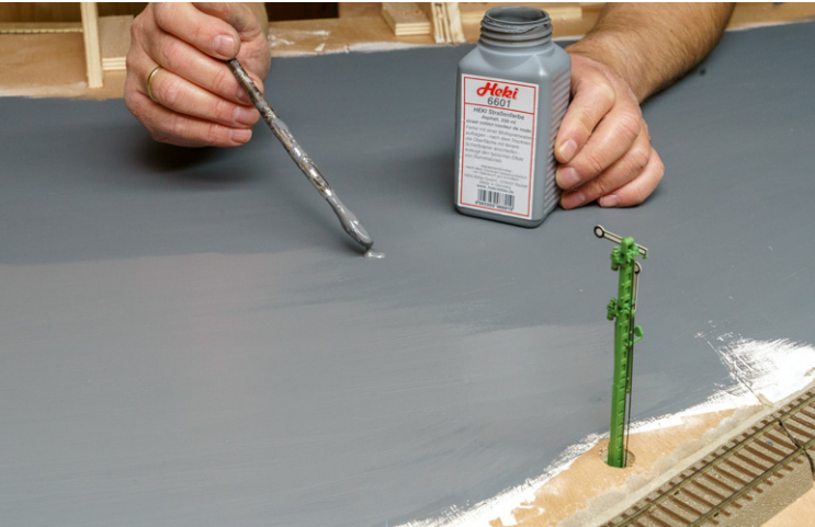
Asphaltarbeiten: Die Oberfläche der Straße sowie die Grundplatte der Kleinstadt werden sauber verspachtelt und anschließend bemalt.
